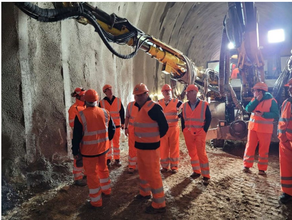
08.07.2025 Visite travaux tunnel les Epoisats directeur CFF Suisse Romande David Fattebert
