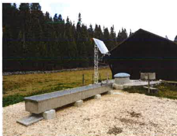
Exemple de pompe solaire et bassin de 1'000 litres
