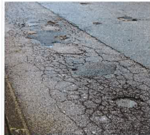
Des nids-de-poule partiellement rebouchés à l'aide d' enrobé à froid en Savoie.
