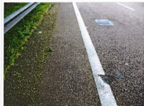
Sur l' autoroute un manque de matière et une réparation parfaite.
