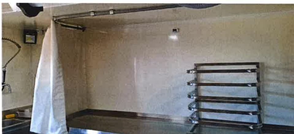
Ci-dessous sont des exemples de finition, après la pose des panneaux isolant en polystyrène par l'entreprise *RAY Enveloppe du bâtiment*. Il s'agit de la zone de fabrication du chalet de la Duchatte. Cette solution d'isolation a fait ses preuves et la réalisation des travaux est irréprochable.
