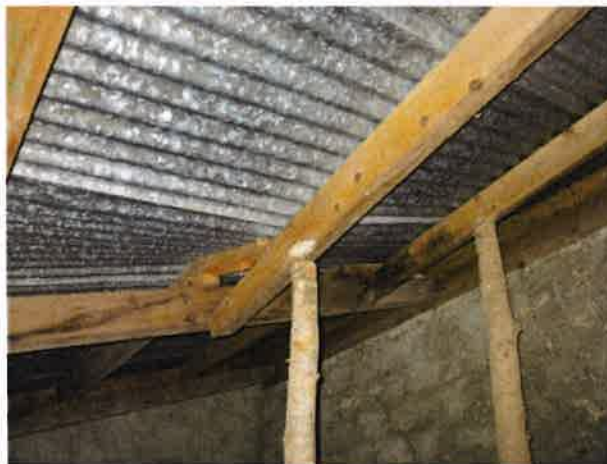
Poutraison de l'appentis (Annexe)
