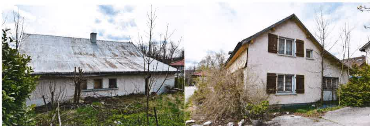
Image 3 : Façade nord et est
