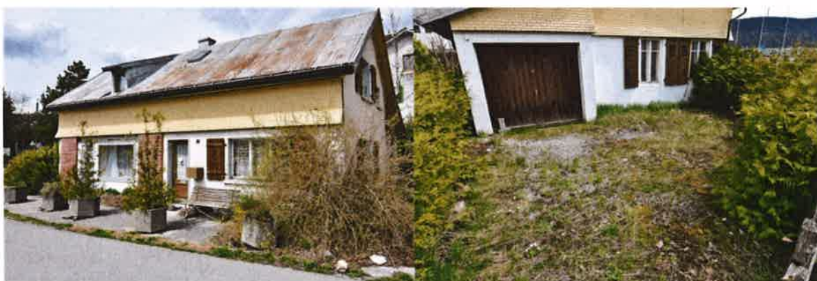
Image 2 : Façades sud et ouest
