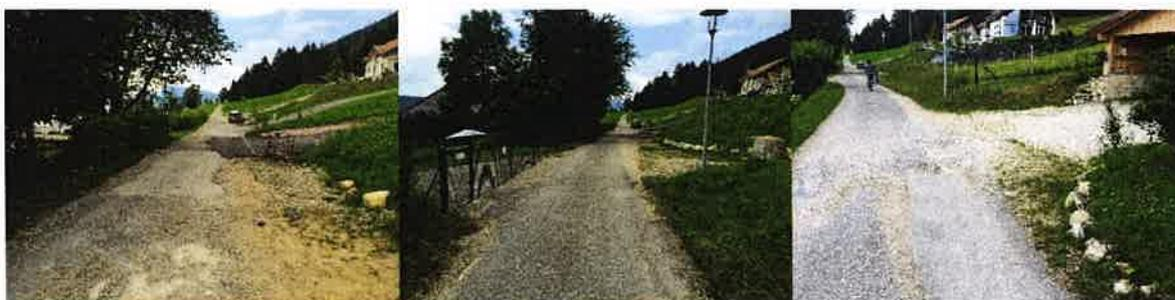
Les eaux de surfaces amont débouchent sur cette route sans grilles et se déversent sur les terrains en aval provoquant des inondations. Ces eaux doivent être récoltées et acheminée dans les collecteurs d'eaux claires existants.
