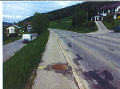
Au vu des résultats des mesures de portance, les travaux de réfection de la chaussée sont limités à la couche de roulement.
